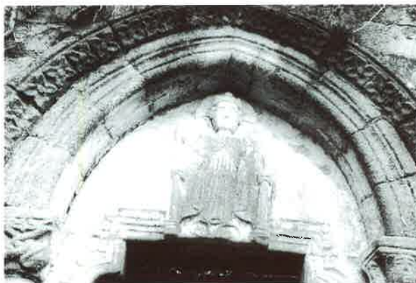
Fig. 6. Vista parcial de la puerta.
