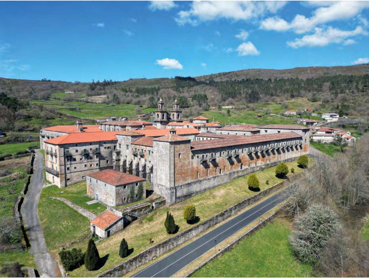
Mosteiro de Oseira. Fachada SO Couvent d'Oseira. Façade sud-ouest
