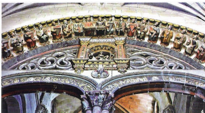
Archivolta del vano central del Pórtico del Paraíso.
