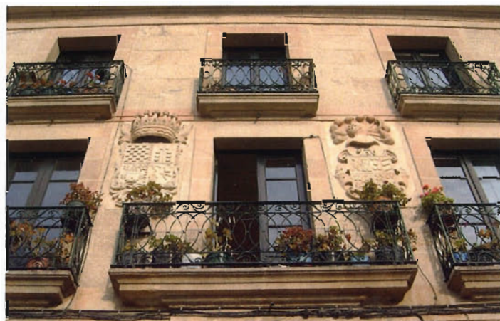
Detalle de una fachada en la plaza de San Marcial.
