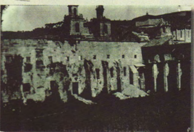
Aspecto del monasterio antes de la restauración.
