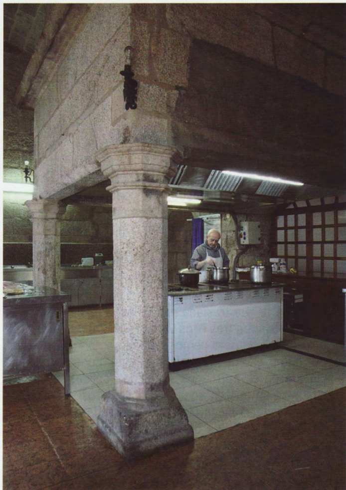
Cocina tras la restauración.
