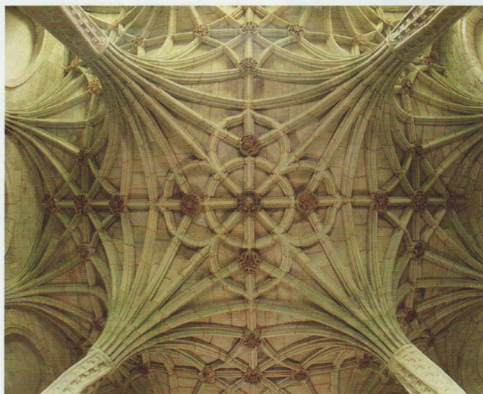
Bóveda de finales del siglo XV de la antigua sala capitular.
