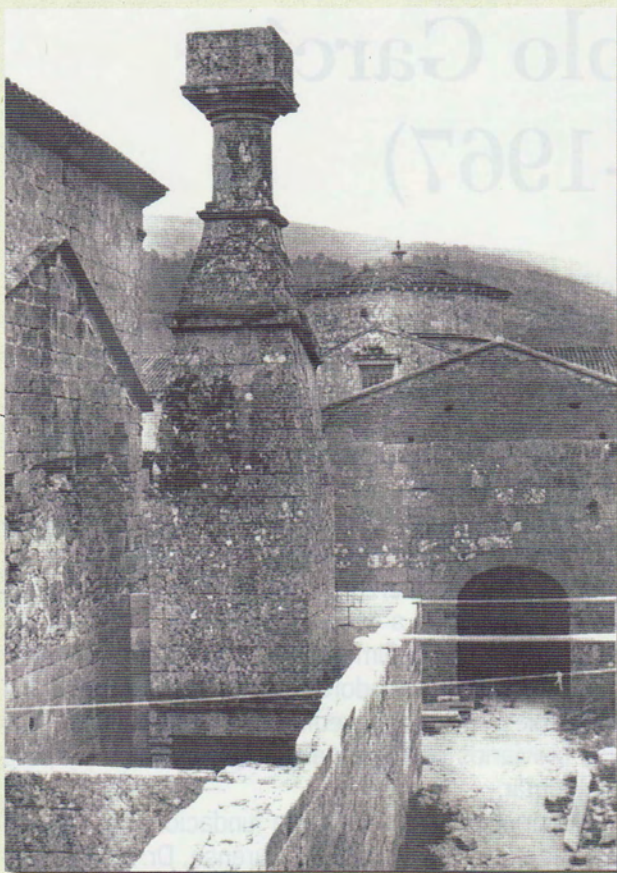
Chimenea del calefactorio.
