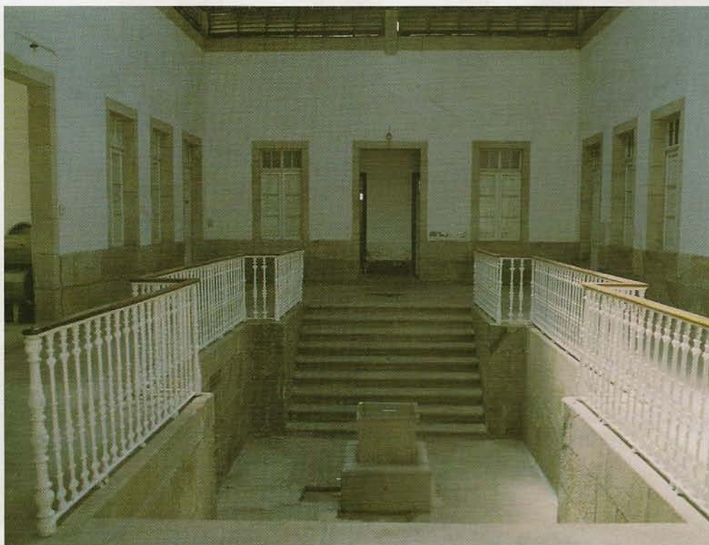
Las aguas de Fontenova brotan en un pozo de un metro de profundidad, con un caudal de 42 litros por minuto, a una temperatura de 17° C.
