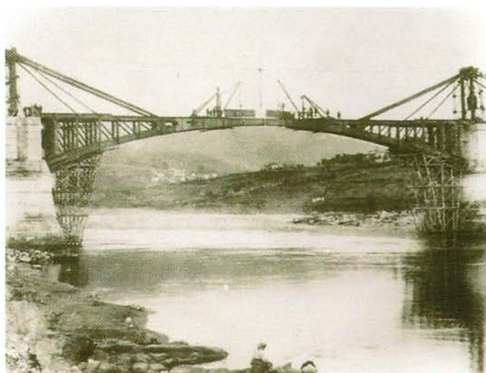
Construcción del Puente Nuevo.
