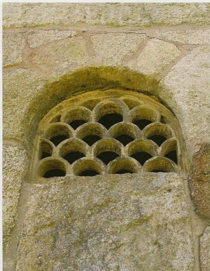
Celosía de Santa Comba (Bande).
