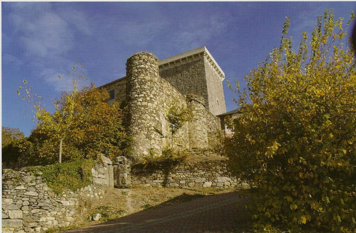
El castillo de O Bolo, reconstruido por Joan Pimentel, constaba de una muralla ancha, circular, con dos torreones y torre del homenaje, elementos que se conservan en la actualidad.
