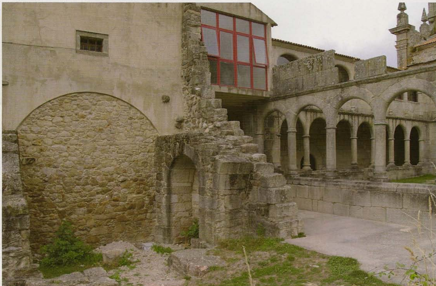
Claustro restaurado de planta rectangular, adosado al costado meridional de la iglesia. Las dependencias del monasterio sirven de oficina al Ayuntamiento y vivienda del párroco.
