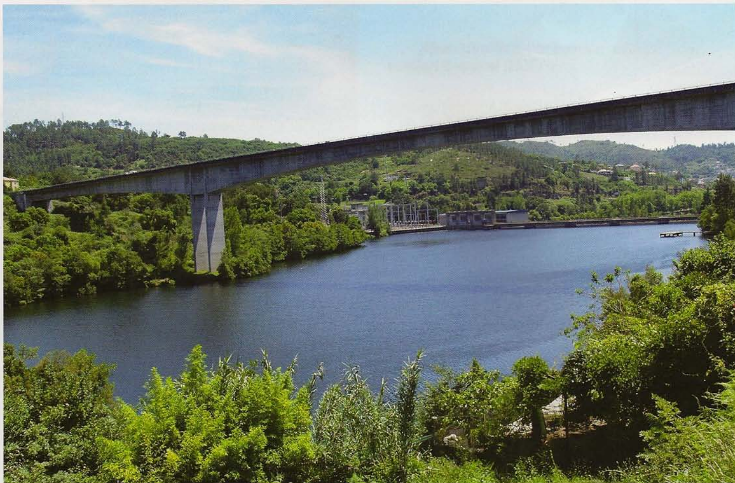
Embalse de Velle y puente de unión entre la carretera de Santiago y la de Monforte.
