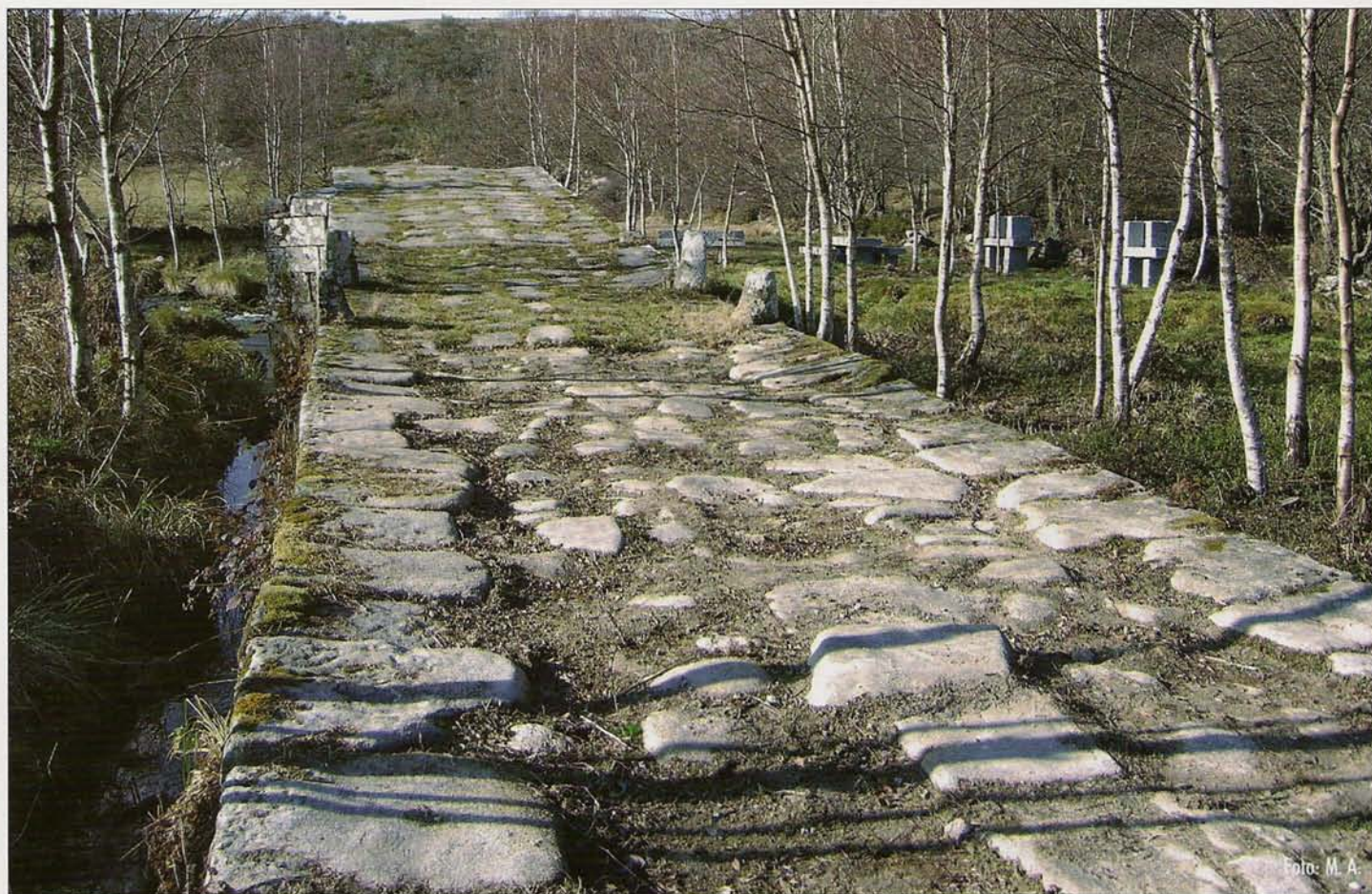
▲ Detalle del puente romano de Vilariño Frío que formaba parte de la Vía Nova.
