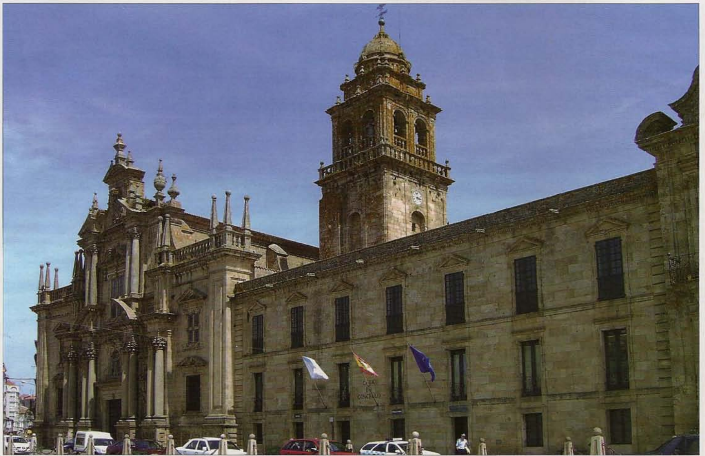
▲ Iglesia y monasterio de San Salvador, comúnmente denominado San Rosendo.
