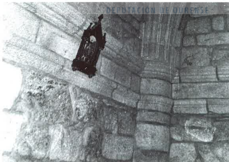
Fotografía N° 38 Detalle arranque de la bóveda Capilla Mayor. Santuario de Nª Sª del Cristal
