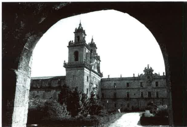
1. Las fachadas del monasterio e iglesia desde el arco de entrada.
