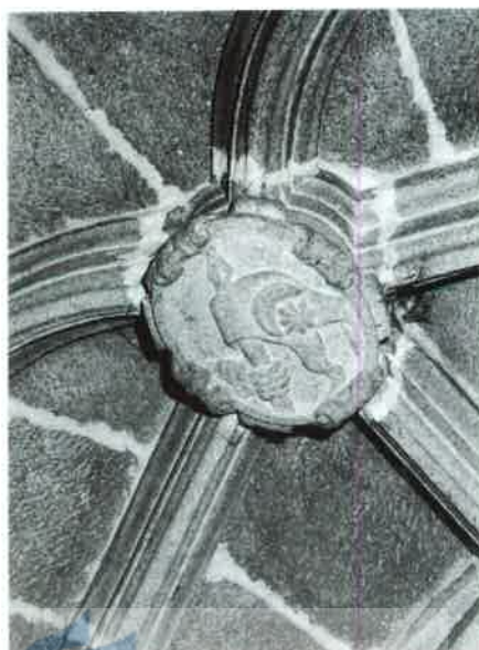
Fotografía N° 6. Motivos heráldicos en la bóveda.
