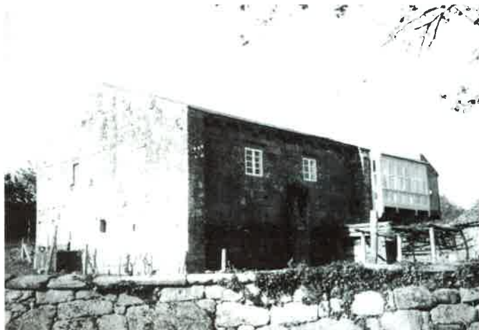
Fig. 1. Vista sur-oeste del edificio.
