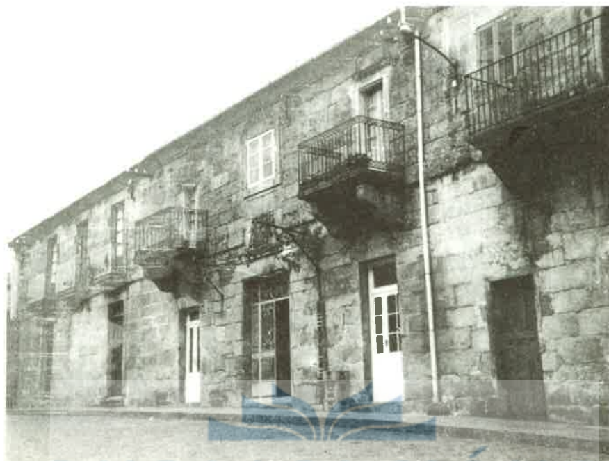
1. Casa de Osera en donde estuvo instalada la botica del Monasterio.
