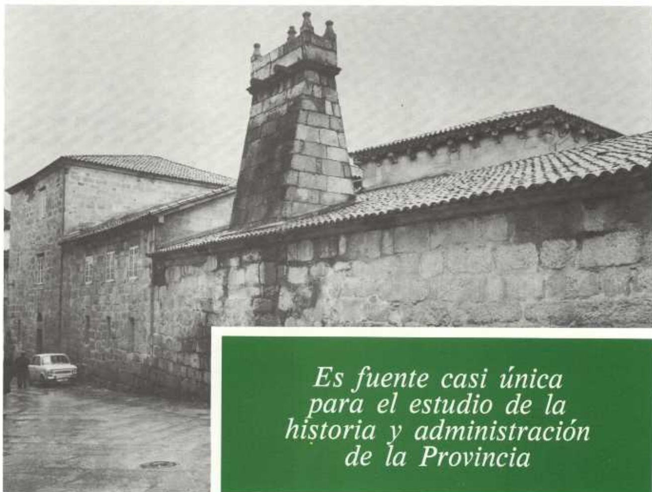
Fachada del A. H. P. de Orense.
