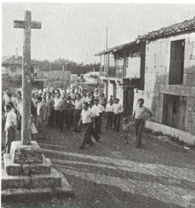
Carretera de San Amaro
