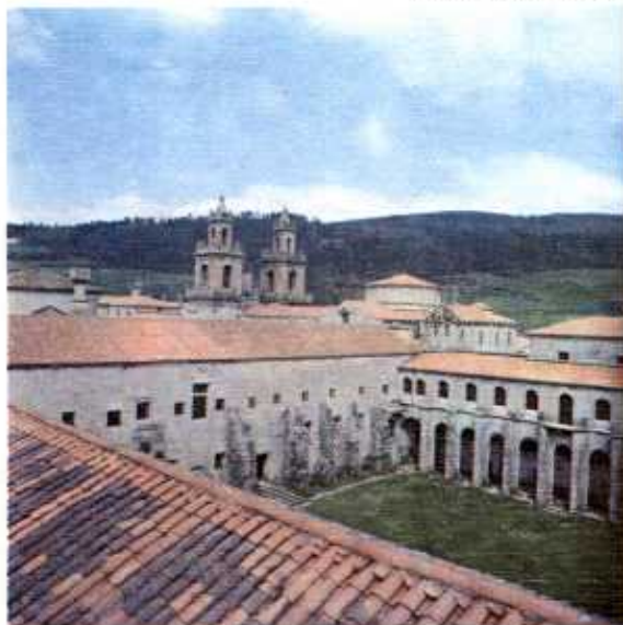
Patio de los Pináculos
