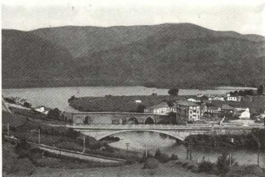
LA RUA. Puentes nuevo y romano sobre el Sil.
