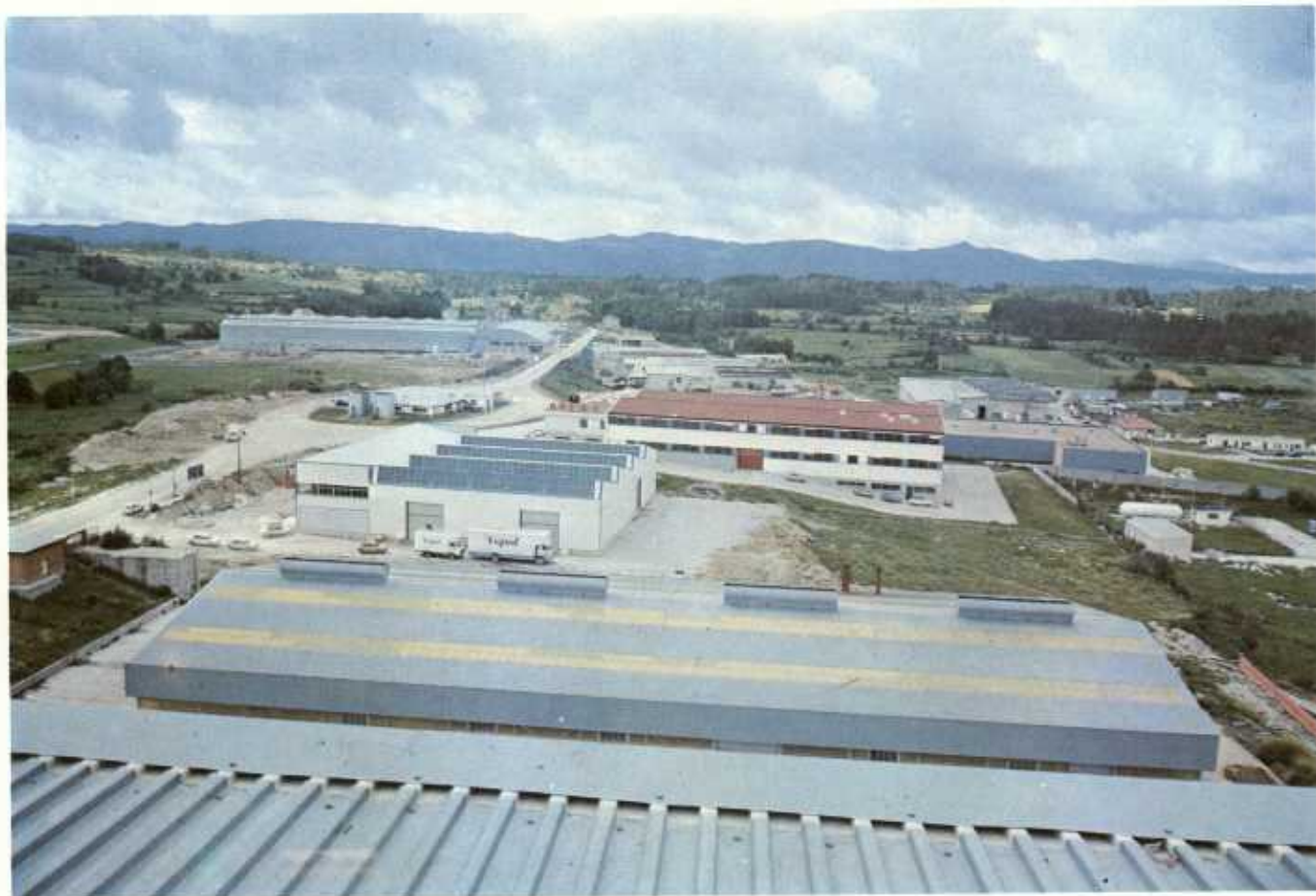
Panorámica parcial, interior y exterior fábricas del Polígono
