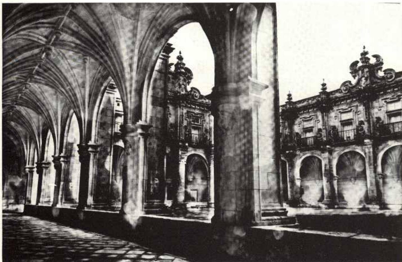
Claustro de San Rosendo
