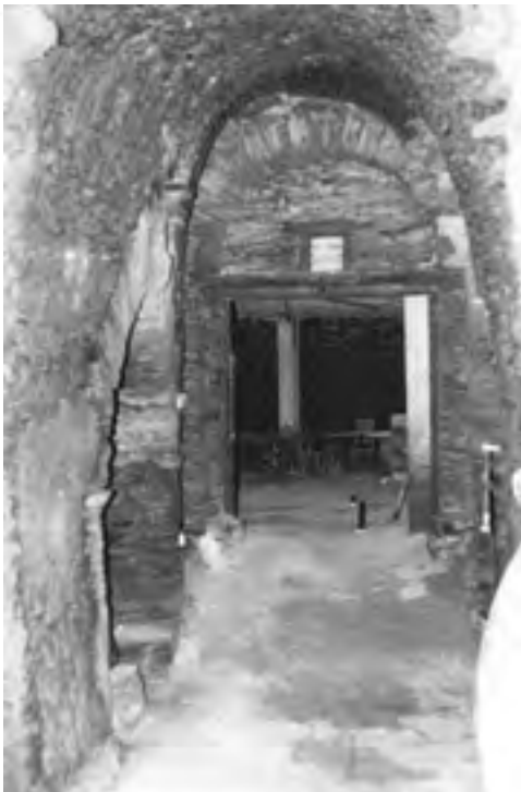
Reforzo no interior da adega-cova nas Covas de Vilarinho en Valdeorras
