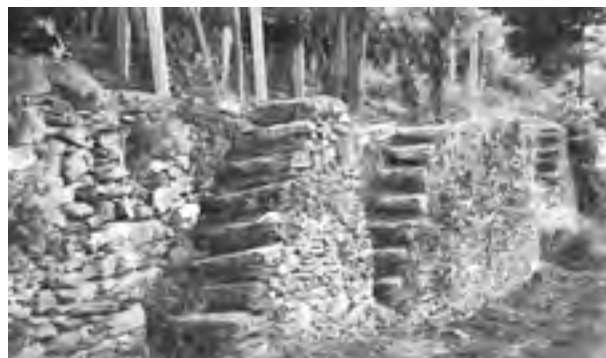
Escaleiras nos muros dos socalcos en Paradela (Castro Caldelas)
