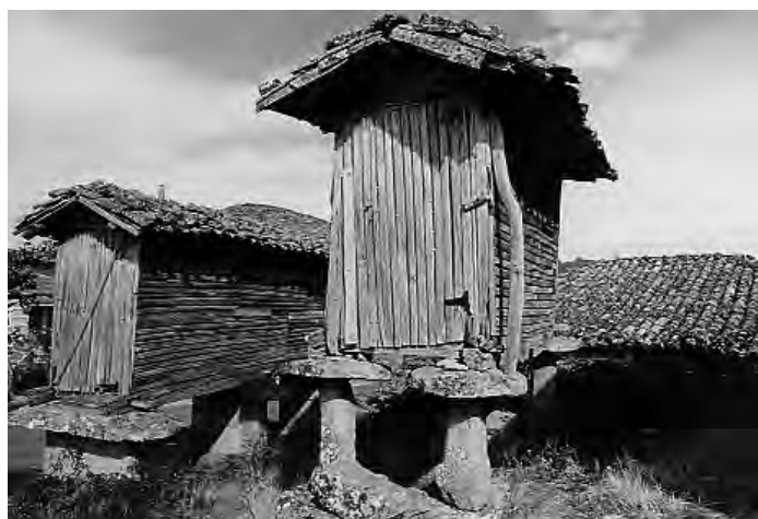
O graneiro péchase con panos continuos de doelas, xeralmente verticais, fixadas por faixas ou travesas horizontais.
