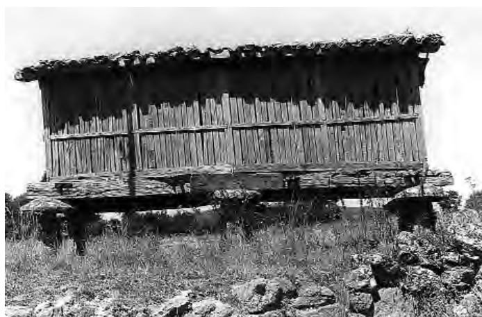
O graneiro péchase con panos continuos de doelas, xeralmente verticais, fixadas por faixas ou travesas horizontais.
